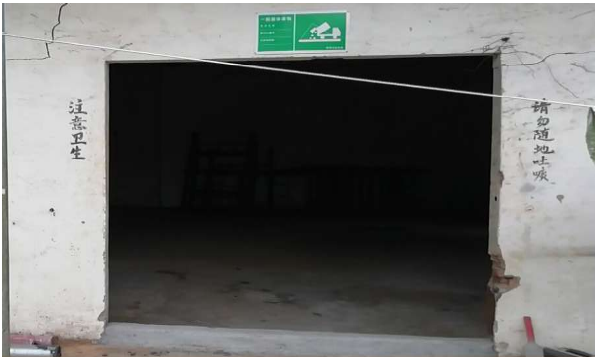
照片 4-4 一般固废暂存间
