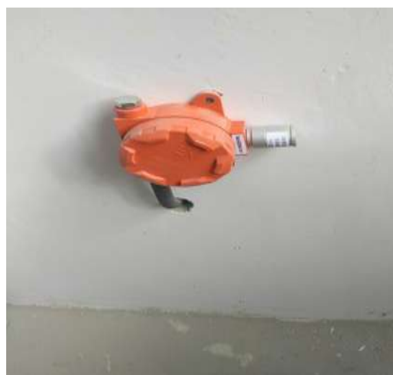
照片 4-8 可燃气体探测器
