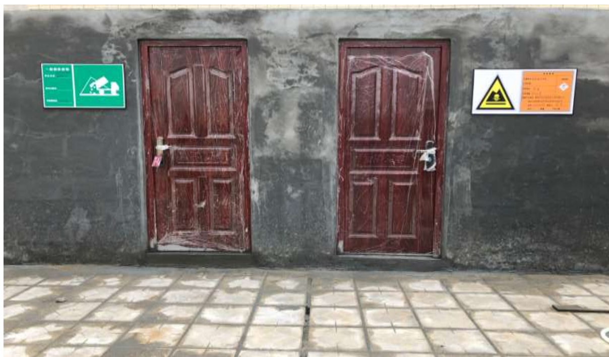
照片 4-9 一般固废临时存放区、危险废物暂存间
