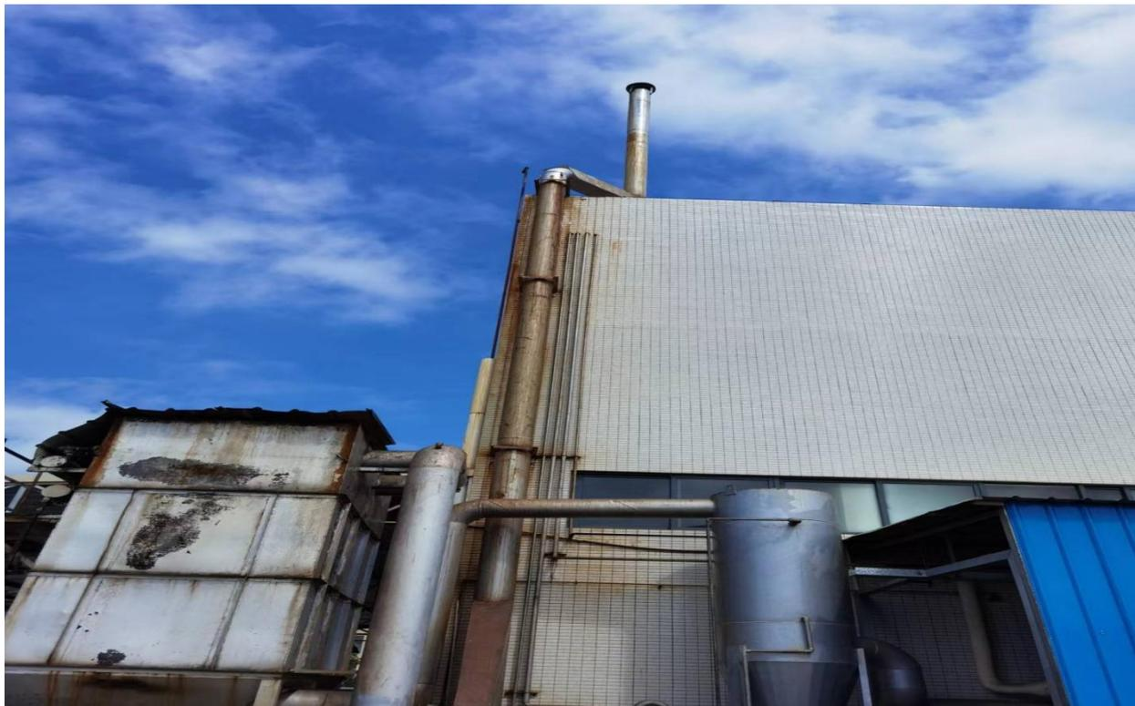
照片 4-2 加热器生物质燃烧废气排放
