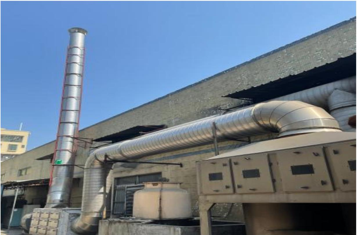
照片 4-4 电熔、压铸工序废气排放口
